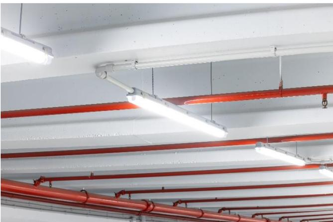
DALI-kompatible LED-T8-Röhren ermöglichen eine effizientere Steuerung und Überwachung
