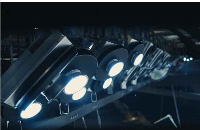
Jeder Scheinwerfer verfügt über zwei optische Module, die eine präzise Steuerung der Lichtintensität ermöglichen
