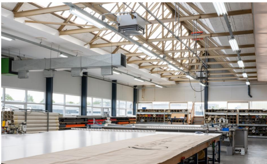
T8 EM PRO ULTRA OUTPUT LED Röhre direkt verbunden mit den 230V mains.
