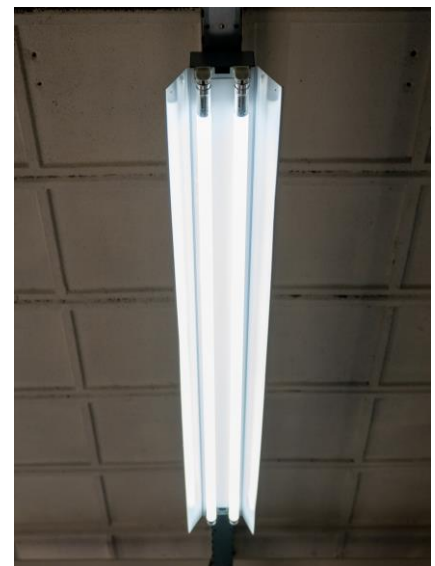
T8 EM PRO ULTRA OUTPUT LED Röhre direkt verbunden mit den 230V mains.
